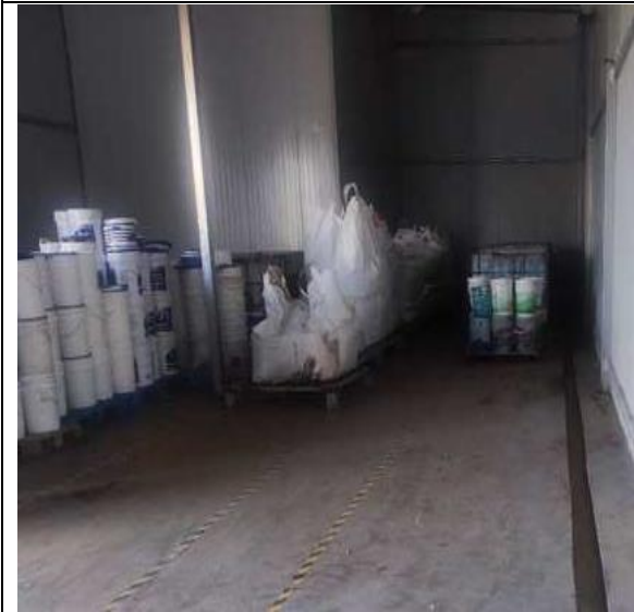
危废库内地面防腐防渗
