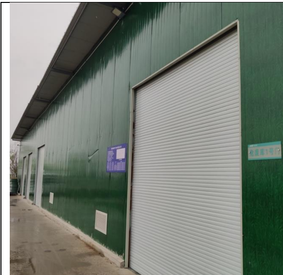
危废暂存场所
