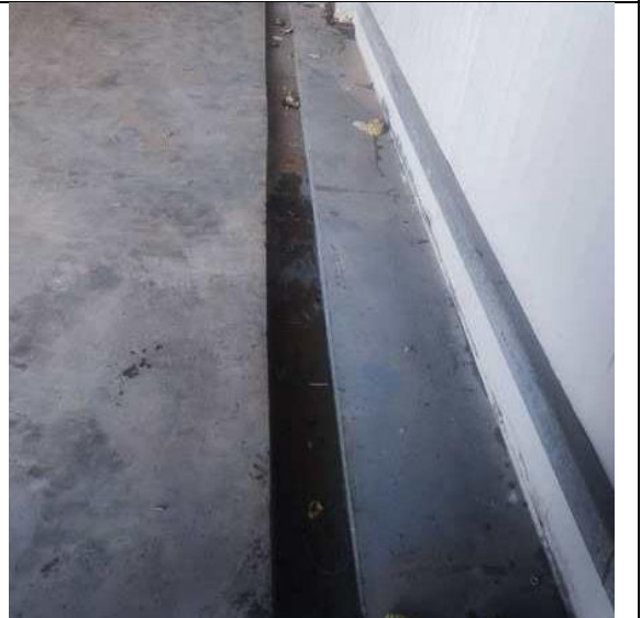
危废库内四周导流槽
