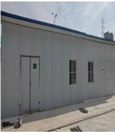
污水总排口在线监测设备站房
