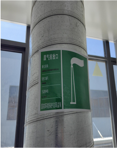
DA005 排放口标识牌
