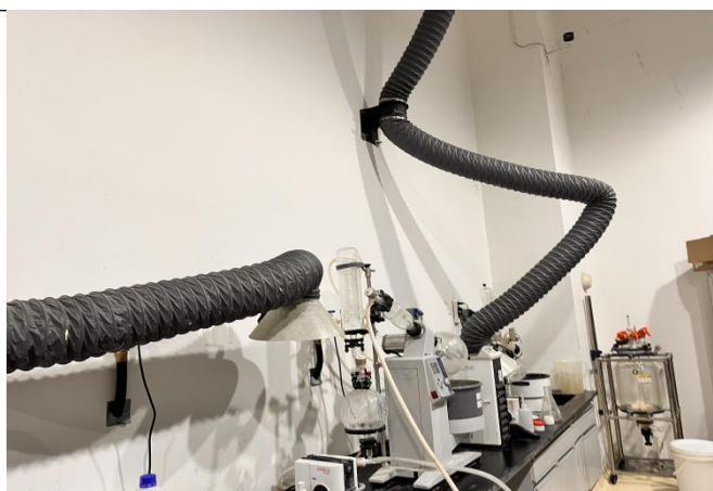
催化剂配制区集气管道
