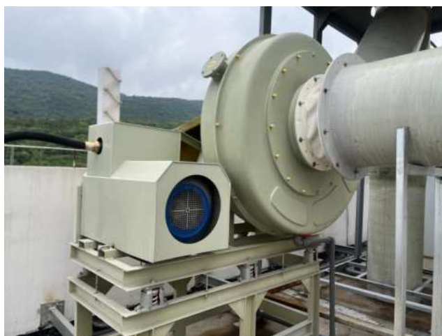
图 4.1-3 风机隔声罩
